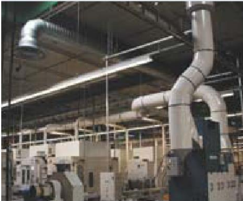
Vue générale d'un réseau de captage de fluide de coupe avec groupe de filtration et conduit d'arrivée d'air de compensation
