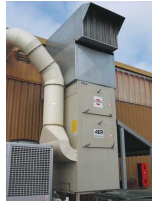
L'air pollué est filtré puis rejeté vers l'extérieur
